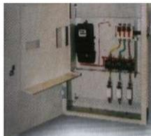
Шкафы учёта с рубильником предназначены для приёма и учёта активной (ШУР, ШУРП) и реактивной (ШУР 2, ШУРП 2) электроэнергии напряжением 380В, 50 Гц, а также для защиты отходящей линии при перегрузках и токах к.з.
